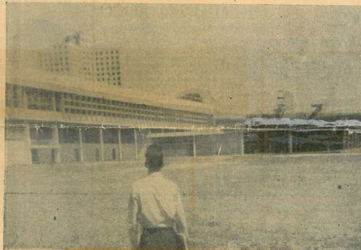
Aspecto do Pavilhão dos Dormitórios, o primeiro já construído dos conjunto de pavilhões que comporá o futuro Internato do Pedro II
